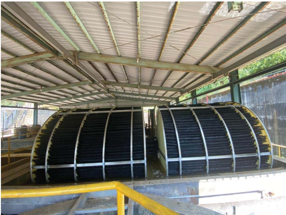
圖 3-7 網狀式旋轉生物圓盤之實場應用
